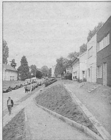
■ Les logements sociaux de la Cité Jardin
